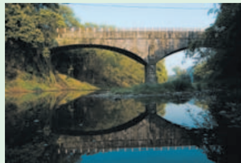
橋の内部に疏水が通る御坂サイフォン橋(志染町)
